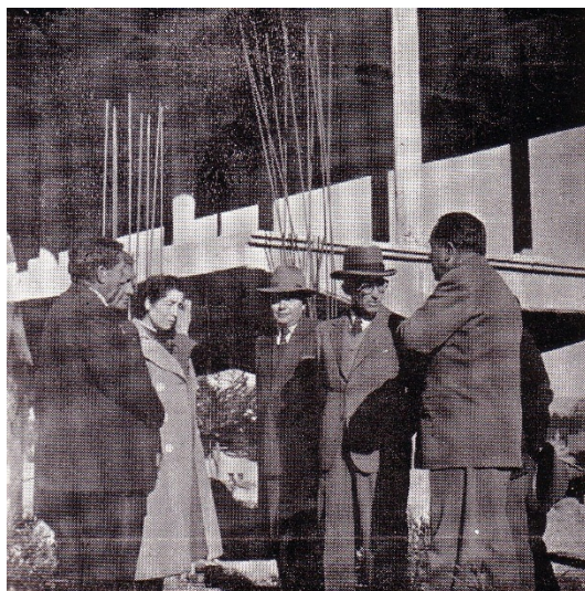
Edificaciones Escolares. Núcleo de Villa Victoria.
