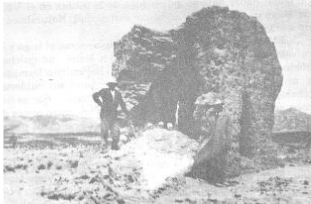
UNA CHULLPA COLLA DE ORURO, con uno de sus lados derruido, lo cual permite ver la estructura de su construcción interna. En algunas chullpas la falsa bóveda termina juntándose, como en el presente caso, en otras esa terminación se hace mediante una serie de dinteles de piedra.
