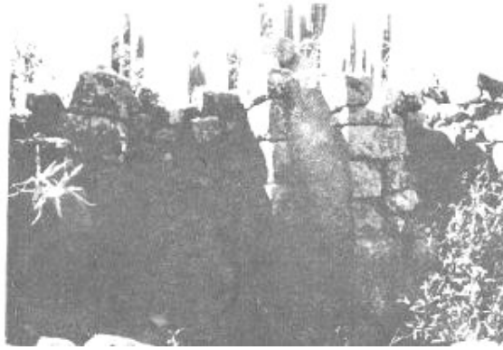
MUROS INTERNOS DE UNA HABITACION DEL GRAN TEMPLO DE ORONCOTA, de planta escalonada, en donde se puede apreciar el fino trabajo de la piedra. Aunque hoy está muy destruida, es uno de los grandes templos incaicos de Bolivia. Provincia Linares, Potosí, sobre el Pilcomayo
