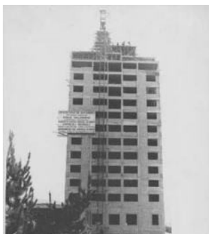
El edificio del "Monoblok" en plena construcción. En la ejecución de la obra participaron activamente las empresas de Giovanni De Col y Rafael Gisbert.
