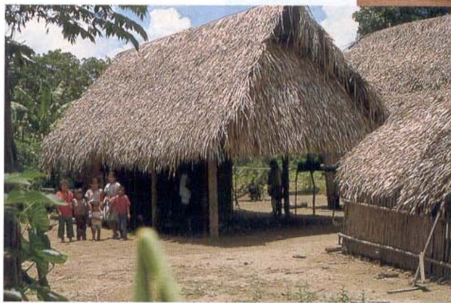
(103) La mayoría de las viviendas Yuracarés tienen un alero en los dos extremos que llaman "cola de pato". Dichos aleros, que se han constituido en una característica de las viviendas Yuracarés, tienen la función de proteger el interior de las fuertes lluvias. Foto: La Misión, 1996.
