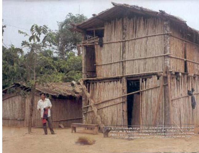
(110) Reciente casa de Jorge Vilche, que se constituye en una innovación dentro de la tradición arquitectónica de los Yuracaré. Es de dos pisos, y tiene una típica escalera Yuracaré para acceder exteriormente a la entrada del segundo piso. Foto: Puerto Patiño, agosto del 2004.
