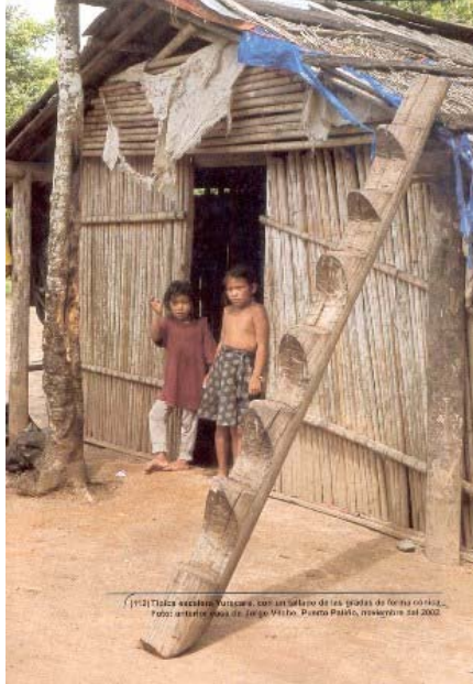
(112) Típica escalera Yuracaré, con un tallado de las gradas de forma cónica. Foto anterior casa de Jorge Vilche, Puerto Patiño, noviembre del 2002.
