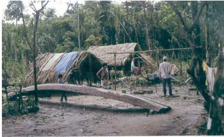
(28) Las viviendas originales Yuracarés tenían techos a dos aguas que bajaban hasta el piso, con entradas en los extremos. Foto: vivienda en el río Chapare, febrero de 1994.
