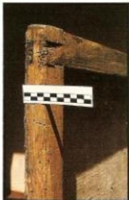
Detalle del ensamble colonial de un bastidor
