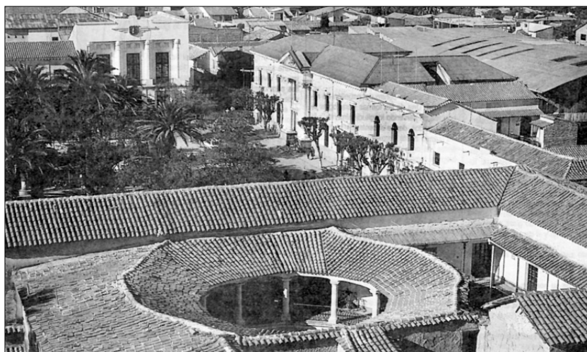
Tradicional vista de los techos de la casa de don Fernando Campero y el patio octogonal en la Plaza Luis de Fuentes. Tarija
