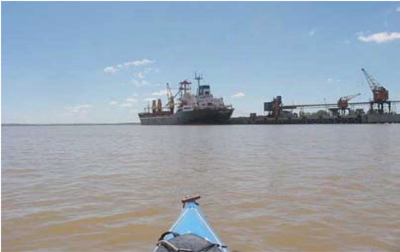
Muelles en Puerto Nueva Palmira.
