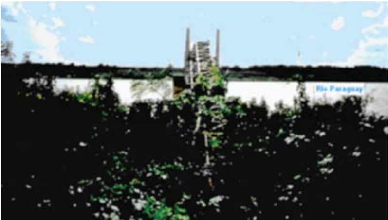
Antigua correa transportadora metálica para carga de hierro desde Puerto Busch hacia la siderurgia San Nicolás de la República Argentina.
