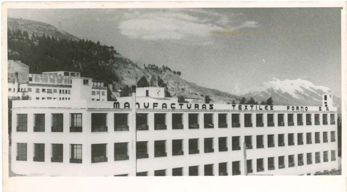
Foto 85. El imponente edificio de las Manufacturas Textiles Forno en una imagen de 1960. Archivo: Eduardo Forno, 2006.
