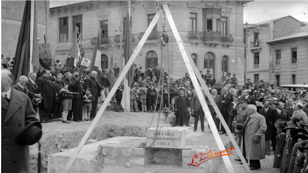
Foto 6. A la izquierda, los miembros de la Sociedad Italiana de Beneficencia Roma observan complacidos como se deposita la piedra fundamental para dar paso a la construcción de la Casa de Italia. Los símbolos fascistas estuvieron presentes en el acto. Algunos italianos de la asociación lucen camisas negras y los niños visten el típico traje "balilla" de las escuadras juveniles del fascismo. Fotografía: Luís D. Gismondi, 1934.
